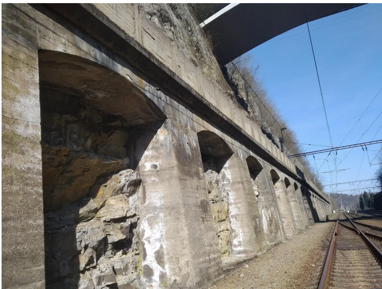
Betonové oblouky se skalní výplní a oplocení na římse
