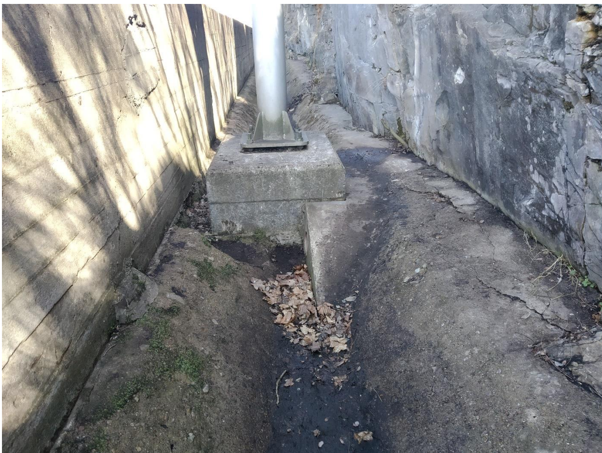
Trakční stožár v ose příkopu – nefunkční odvodnění
