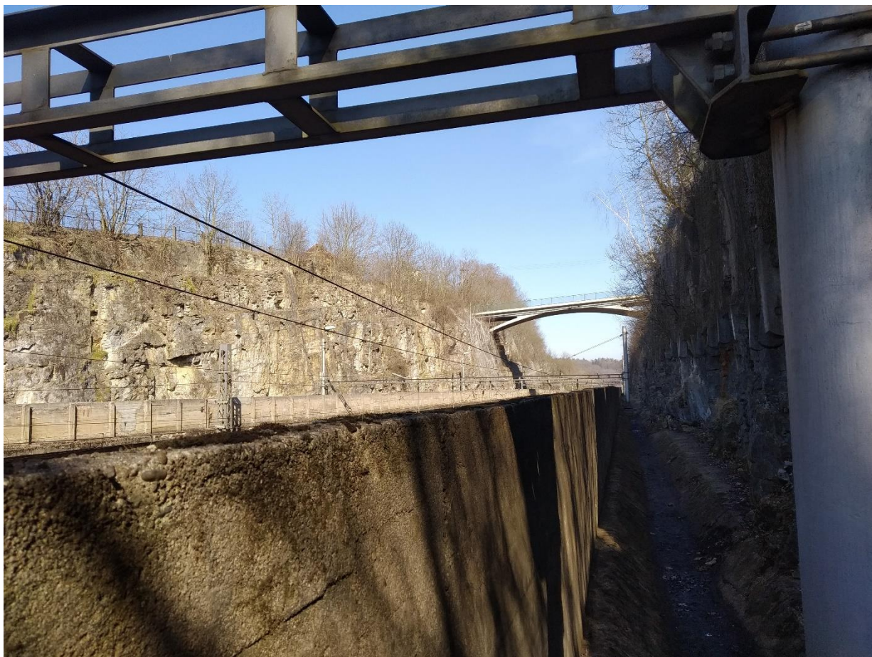
Trakční stožár v ose příkopu – nefunkční odvodnění
