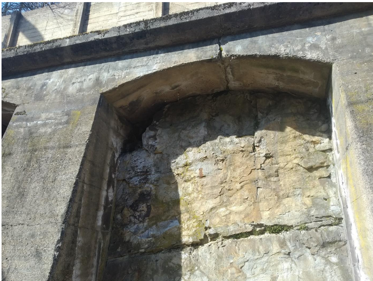
Detail praskliny ve vrcholu oblouku betonové klenby
